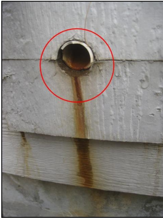
23. Broken drain pipe
